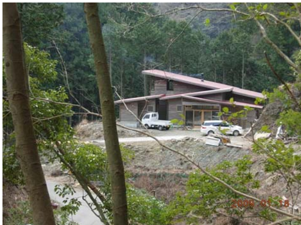
薪ストーブの煙が昇る「森の駅」
