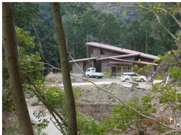
薪ストーブの煙が昇る「森の駅」
